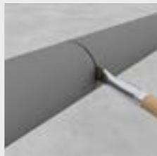
Ca. 10 mm länger zuschneiden: Druckverarbeitung gewährleisten.
