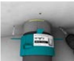
Öffnung mit mineralischem Mörtel verschließen. Ringspalte von 10 mm–25 mm ohne Muffe im Durchführungsbereich können in der Decke mit Missel Brandschutz-Kitt BS-KITT II verschlossen werden. Dübellöcher bohren und Dübel setzen.
