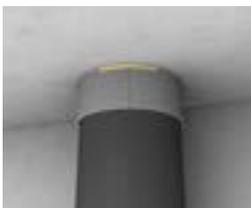
Öffnung mit mineralischem Mörtel verschließen. Ringspalte von 10 mm – 25 mm ohne Muffe im Durchführungsbereich können in der Decke mit Missel Brandschutz-Kitt BS-KITT II verschlossen werden.
