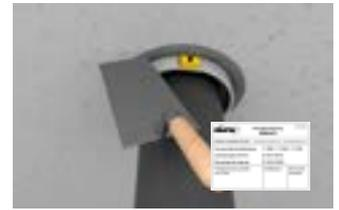
Brandsicherer Verschluss und Kennzeichnung.
