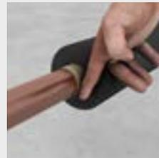
Schnell-Check: Fingerrückenprobe anwenden.
