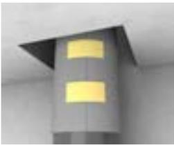
Schaumstreifen mit Klebestreifen um das Rohr befestigen.
