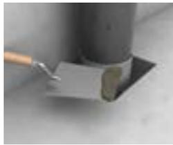
Restöffnung in Bauteildicke mit mineralischem Mörtel verschließen.
