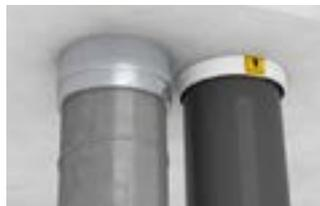
Abstand BSM-KR zu Lüftungsleitung/Absperrvorrichtung (bis DN 125 Typ AVR gemäß AbZ/aBG Nr. Z-41.3-686 Bartholomäus)
