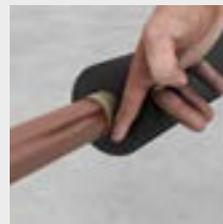
Schnell-Check: Fingerrückenprobe anwenden.
