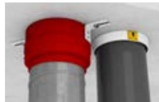
Abstand BSM-KR zu Lüftungsleitung/Absperrvorrichtung (bis DN 125 Typ TS 18 gemäß AbZ/aBG Nr. Z-41.3-556 Wildeboer)
