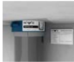
Abschließend Rohrabschottung mit Kennzeichnungsschild kennzeichnen.
