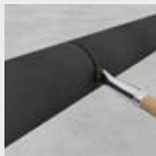
Ca. 10 mm länger zuschneiden: Druckverarbeitung gewährleisten.
