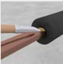
Wichtig: Schlauch- oder Plattenenden umlaufend fest mit der Rohroberfläche verkleben.
