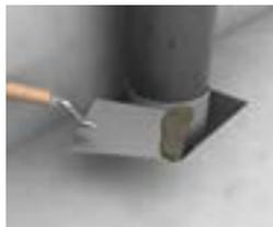
Restöffnung in Bauteildicke mit mineralischem Mörtel verschließen.
