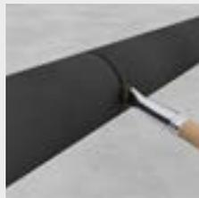
Ca. 10 mm länger zuschneiden: Druckverarbeitung gewährleisten.
