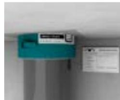
Abschließend Rohrabschottung mit Kennzeichnungsschild kennzeichnen.
