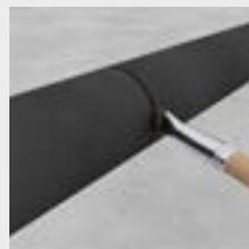
Ca. 10 mm länger zuschneiden: Druckverarbeitung gewährleisten.
