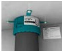
Anschrauben und Rohrabschottung mit Kennzeichnungsschild kennzeichnen.
