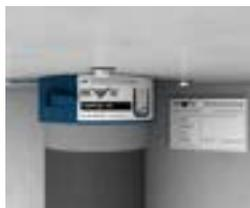
Anschrauben und Rohrabschottung mit Kennzeichnungsschild kennzeichnen.
