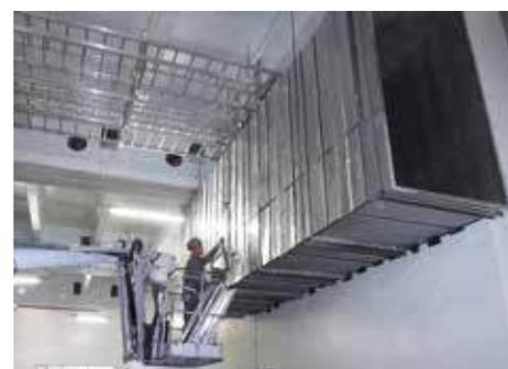
Dämmstoff wurde für die Dämmung des gesamten Rohr- und Kanalsystems der Lüftungsanlage bestimmt. Insgesamt wurden 10.455 m<sup>2</sup> kontinuierliche Arma-Chek Silver Bahnen mit 19, 25 und 32 mm Dicke montiert.
